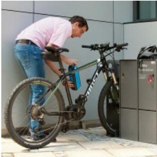
Bei dieser Bauart ist jeder Fahrradhalterung ein Ladepunkt zugeordnet - entweder ein Ladeschließfach oder ein energy-bus-Anschluss.
